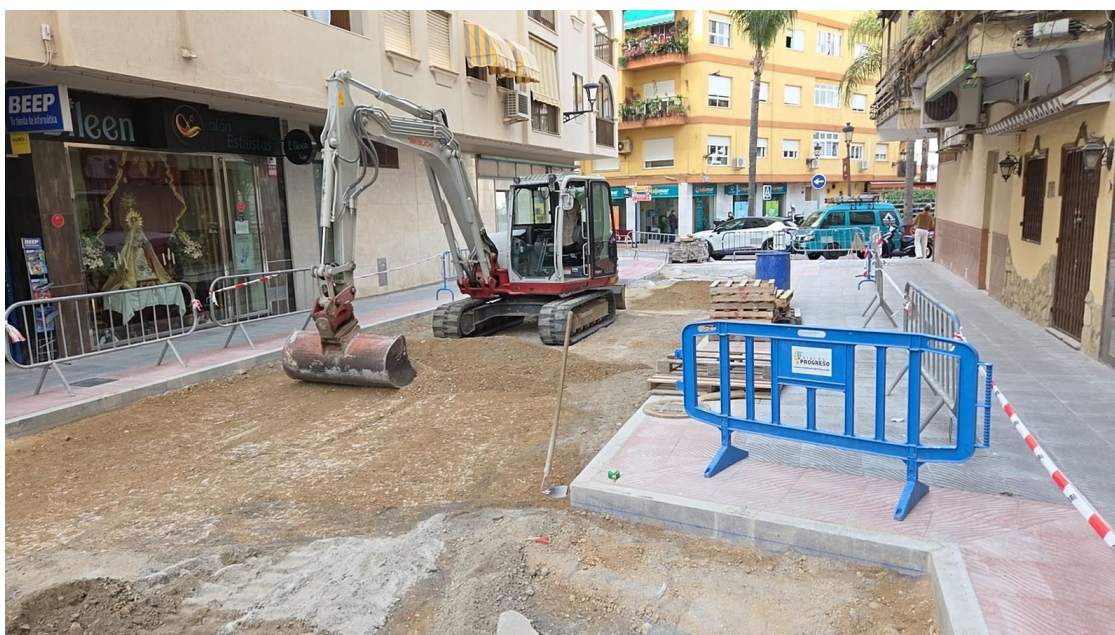
Obras en la calle Granada de Almuñécar / G.H.
